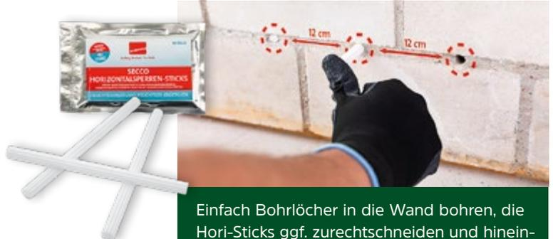
Einfach Bohrlöcher in die Wand bohren, die Hori-Sticks ggf. zurechtschneiden und hineindrücken, zum Schluss das Bohrloch mit z. B. Secco Due) verschließen – fertig.
