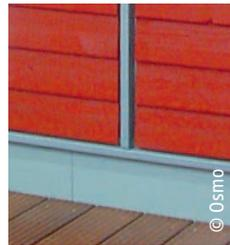
Aluminium-Profile schützen Holzfassaden zusätzlich an sensiblen Schnittstellen vor Staunässe und setzen optische Akzente: Übergangprofile verhindern ein Durchnässen der Holz-Stirnseiten, Eckprofile schützen sensible Kanten und schaffen sichere Übergänge, Bodenprofile schützen vor Spritzwasser.
