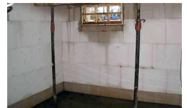
Durchfeuchtetes Kellermauerwerk
