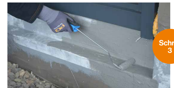
Das eingelegte PCI Barraseal Ready Vlies frisch in frisch mit einer zweiten Schicht PCI Barraseal Ready vollständig überarbeiten.
