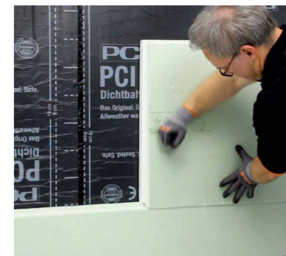
PCI Pecimor DK zur Verklebung von Dämmplatten auf Bitumen-Dickbeschichtungen und KSK-Bahnen.
