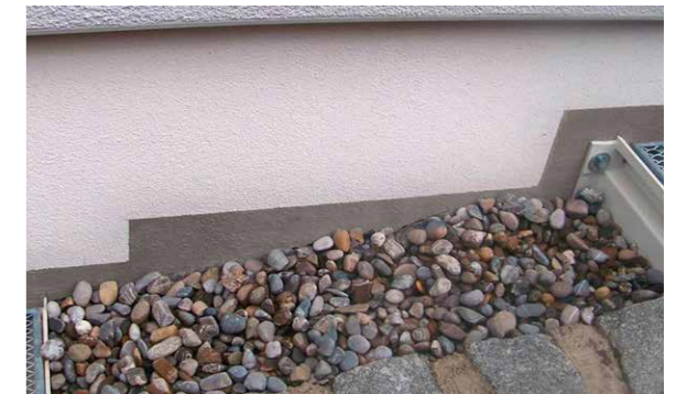
Bauwerksabdichtungen mit PCI Barraseal Turbo können im Sockelbereich so belassen oder überstrichen/überputzt werden
