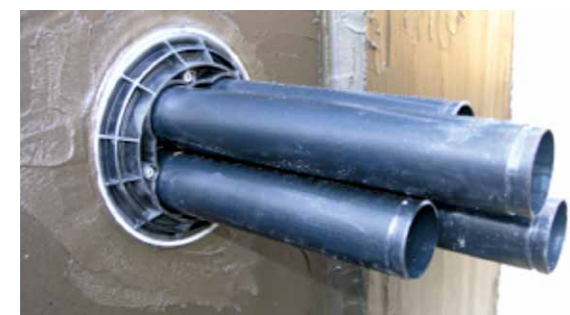
Anarbeiten von PCI Barraseal Turbo an eine Mehrspartenhaufeinführung
