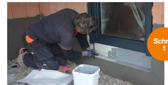
PCI Barraseal Ready mit einer kurzflorigen Rolle oder einem Pinsel flächendeckend auf den vorbereiteten Untergrund aufbringen.
