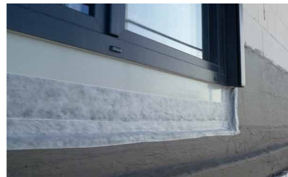
Anschluss Fensterelement mit Fixband PCI BT 42
