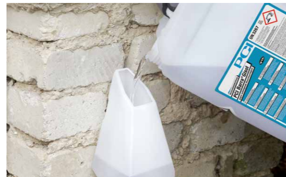
Mauerwerk mit der flüssigen Horizontalabdichtung PCI Barra Gisöl gegen aufsteigende Feuchtigkeit schützen
