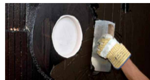
Anarbeiten von PCI Pecimor 2K an einen Klebeflansch
