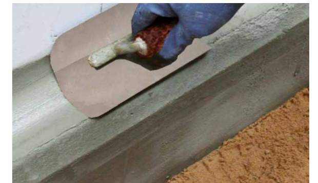
Erstellen einer wasserdichten Dichtungs-/Hohlkehle mit PCI Polyfix plus L
