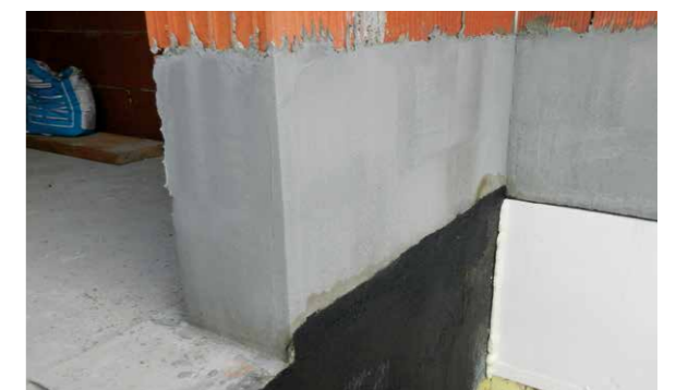
Zwischenabdichtung mit PCI Barraseal
