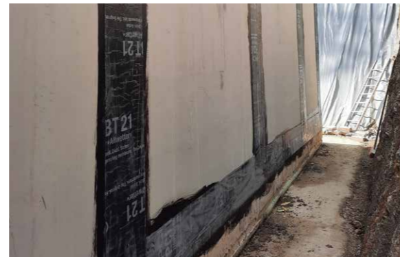
Abdichten von Gebäudetrennfugen mit der KSK-Bahn PCI BT 21
