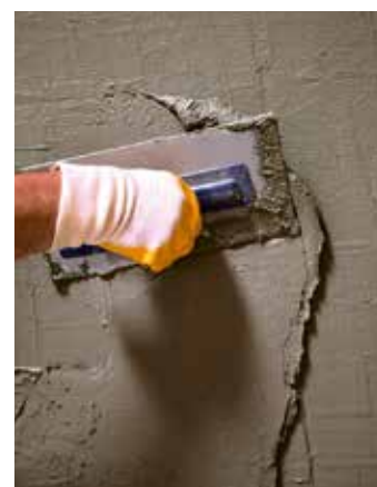
Auftrag im Spachtelverfahren mittels Glättkelle in einer Mindestdicke von 4 mm für eine geprüfte Dichtigkeit gegen 3 m Wassersäule als negativer Wasserdruck. Ebenfalls geeignet zur Herstellung von Hohlkehlen und druckwasserdichten Reprofilierungen.
