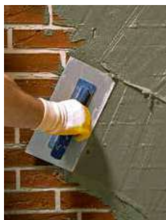
Auftrag im Spachtelverfahren mittels Glättkelle in einer Mindestdicke von 4 mm für eine geprüfte Dichtigkeit gegen 3 m Wassersäule als negativer Wasserdruck. Ebenfalls geeignet zur Herstellung von Hohlkehlen und druckwasserdichten Reprofilierungen.
